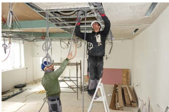
Nakon građevinskih radova slijedi opremanje interijera
