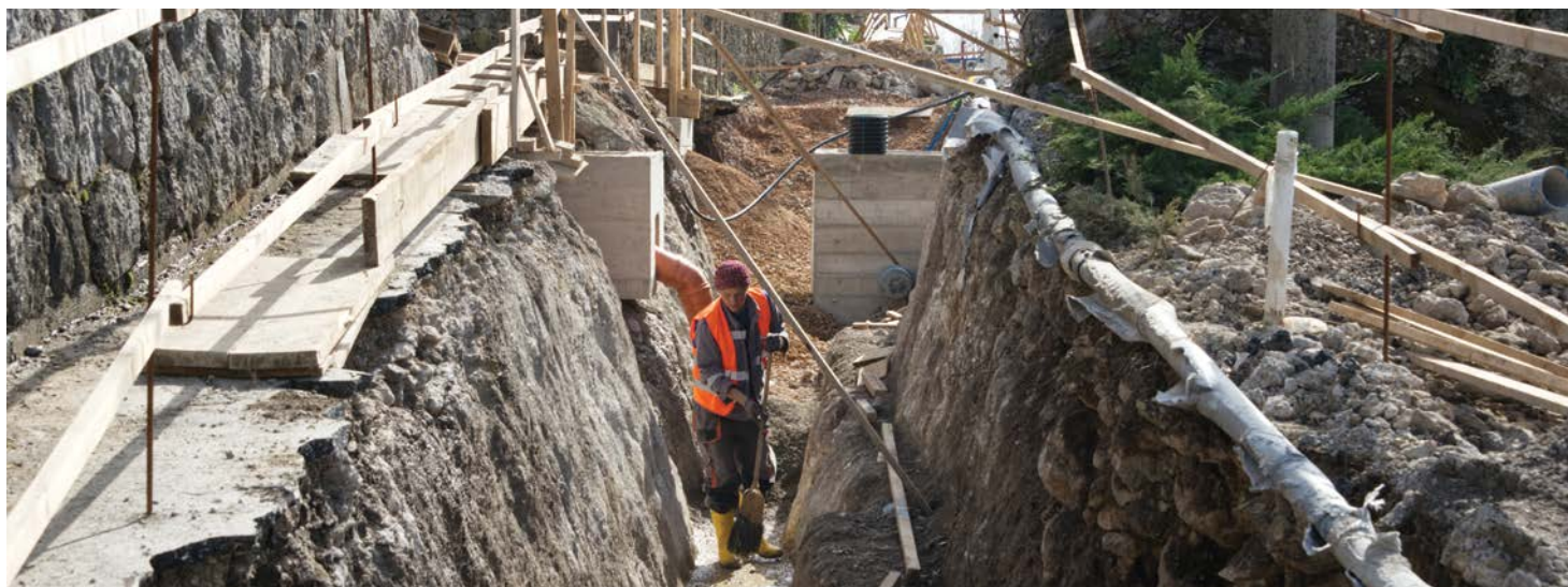
Projekt izgradnje kanalizacije trajat će nekoliko godina
