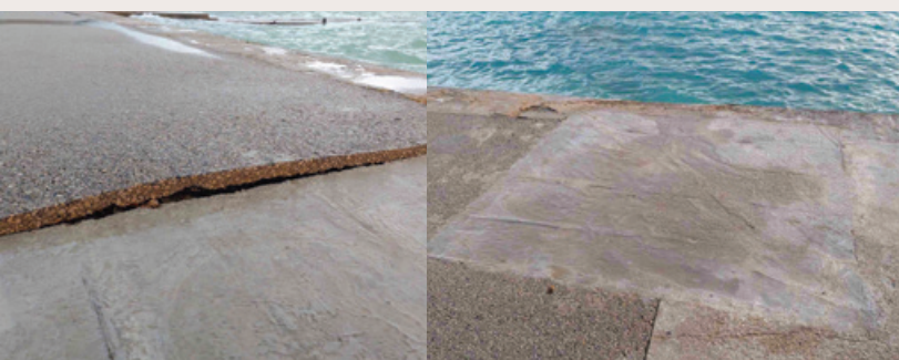
Sanacija dijela šetnice Palada
