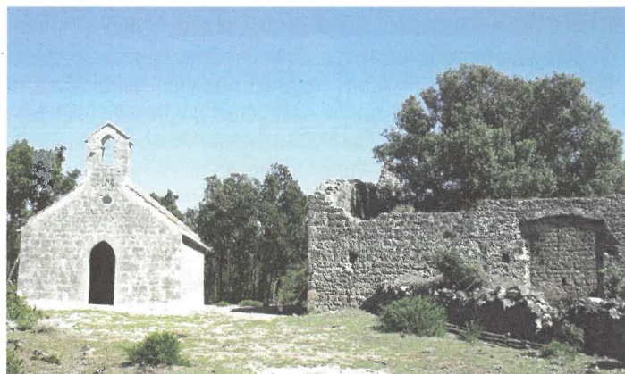
Crkvice Sv. Antona Opata na Parhavcu nakon obnove
