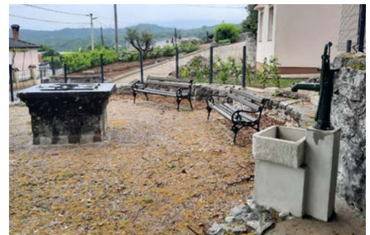
I u Krajevcu šterna s novom pumpom
