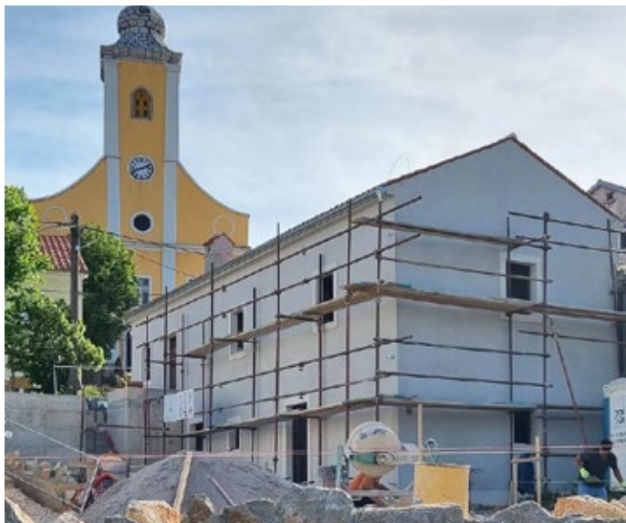
12 | Nastavak izgradnje Etno kuće Marohnić
