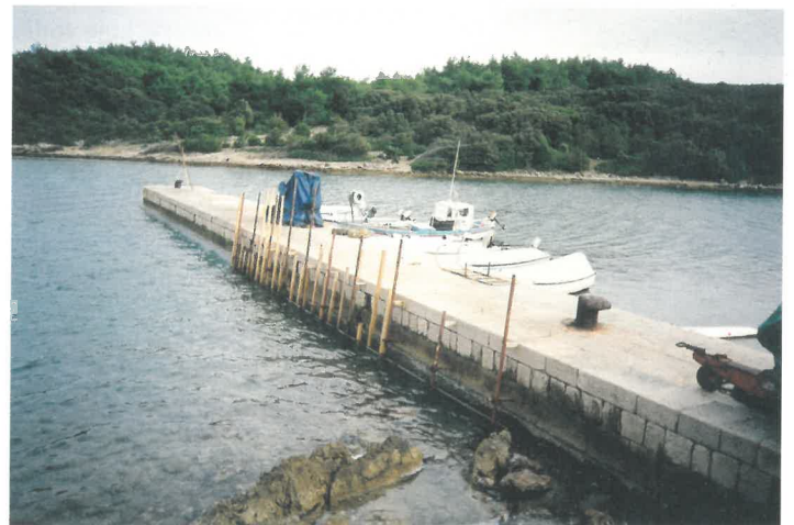
Sanacija rive na Ulu
