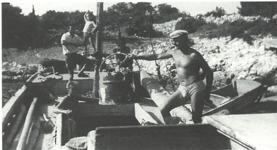
Iskrcaj pijeska ručnim vitlom s bajom
