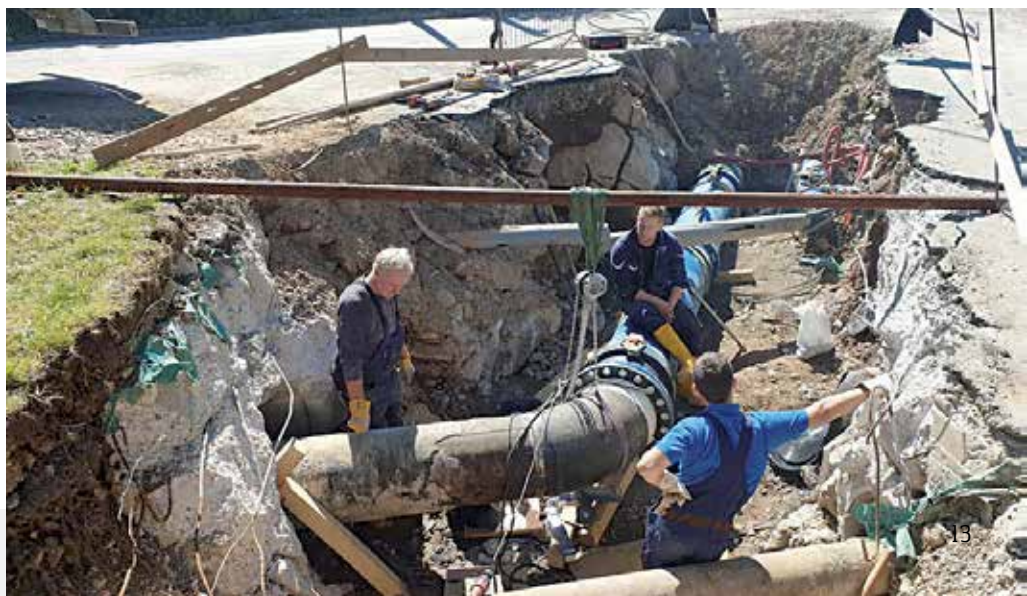
Radovi na prespajanju vodovoda
