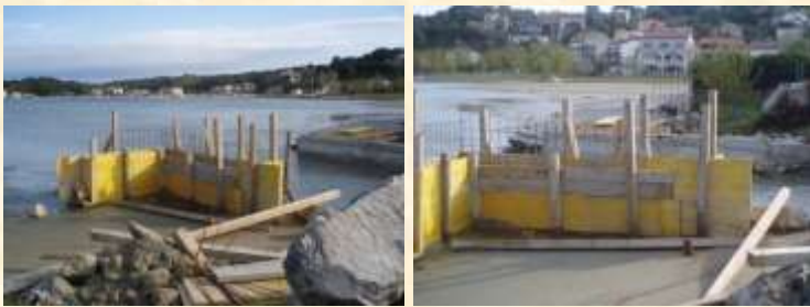
Izgradnja mosta gornji Mel-donji Mel
