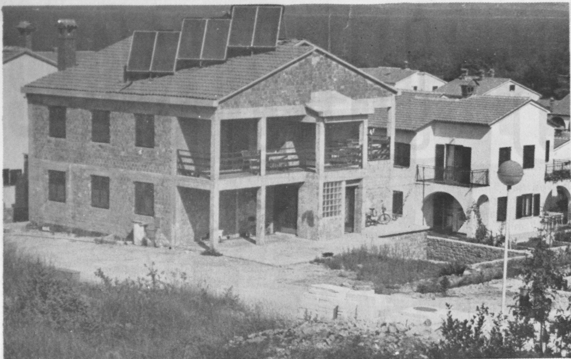
Krajnje je vrijeme da se odrede nova gradilišta. Na slici Drage Skvorca — stambeni objekti novog naselja Zagazine — Mali Lošinj
