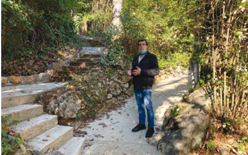
Uređen i betoniran pristupni put i nove stepenice dugogodišnja su želja stanara okolnih zgrada
