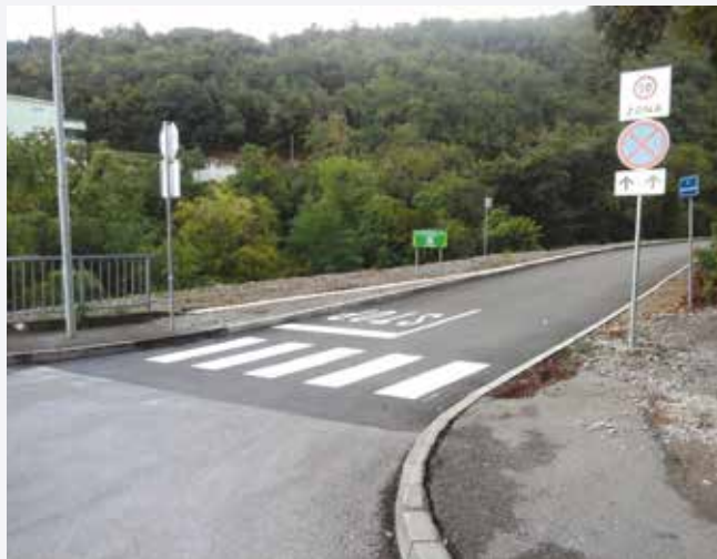
Rekonstruirana i primjereno uređena cesta put Plahuti
