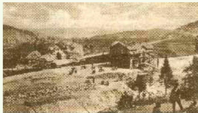
Gradnja prijamne zgrade željezničkog kolodvora u Delnicama 1872. godine. Zgrada je izgrađena na temeljima nekadašnje Lujzinske pošte iz prve polovice 19. stoljeća. Ovo je do sada najstarija pronađena fotografija na kojoj se vidi panorama Delnica s Lujzinskom cestom. Tih godina u Delnicama je živjelo blizu dvije tisuće ljudi.
