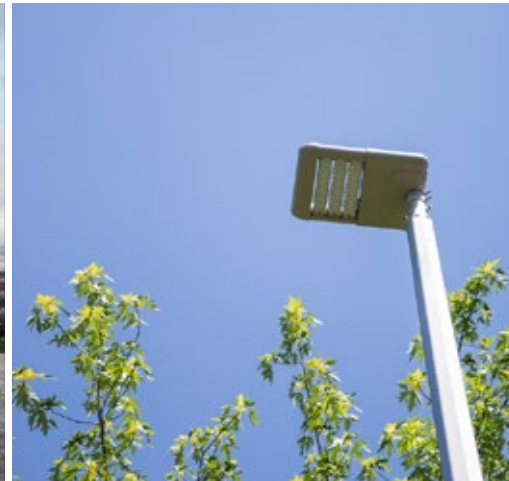
Stupovi postavljeni, do ljeta nova rasvjeta kod glavnih prometnica
