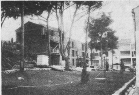
Za 27 dana, zahvaljujući dobroj organizaciji i povoljnim vremenskim prilikama, na gradilištu »PUNTE« stiglo se »pod krov«. foto: M. Kordum
