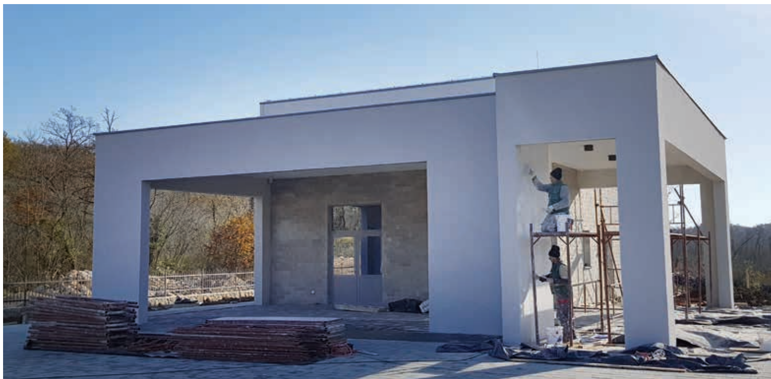
Objekt mrtvačnice je gotov
