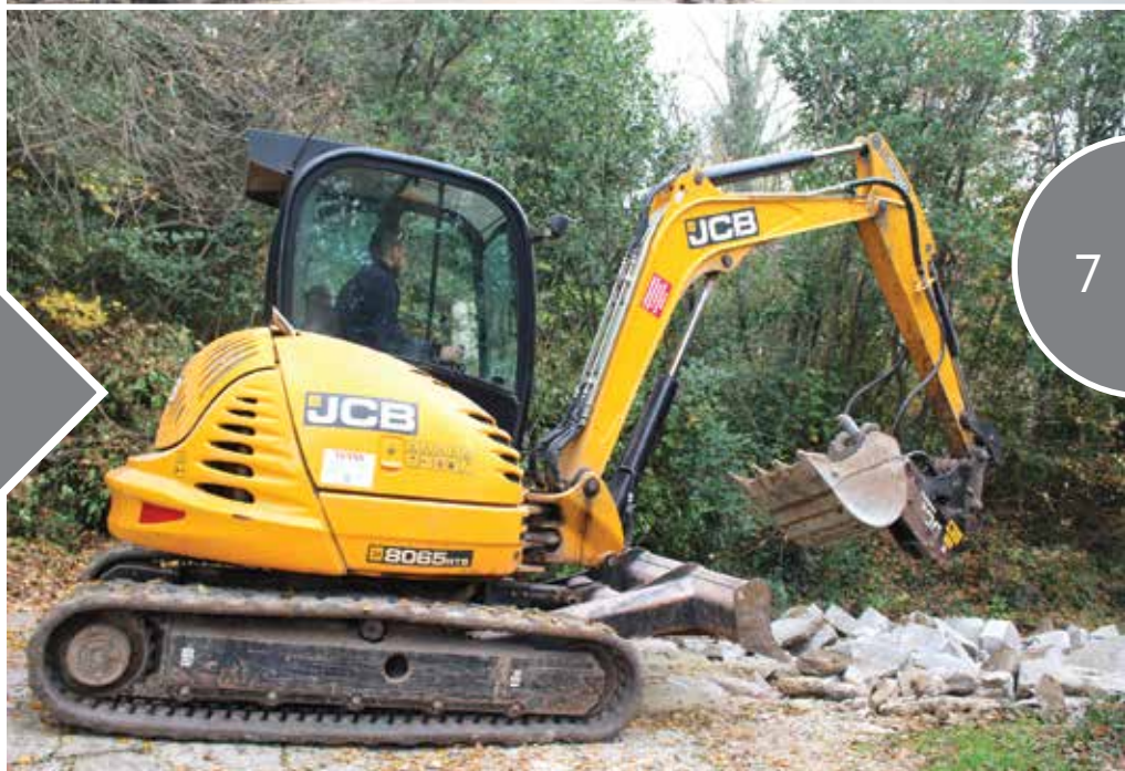
Započeti radovi u ulici Buč
