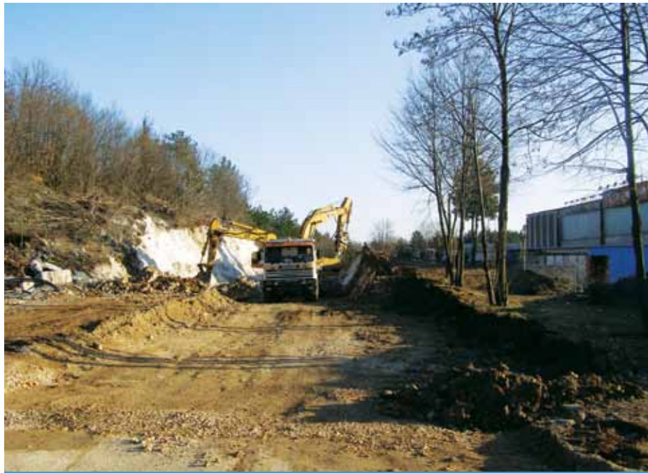
Radovi na rekonstrukciji županijske ceste uz asfaltnu bazu Mariščina
