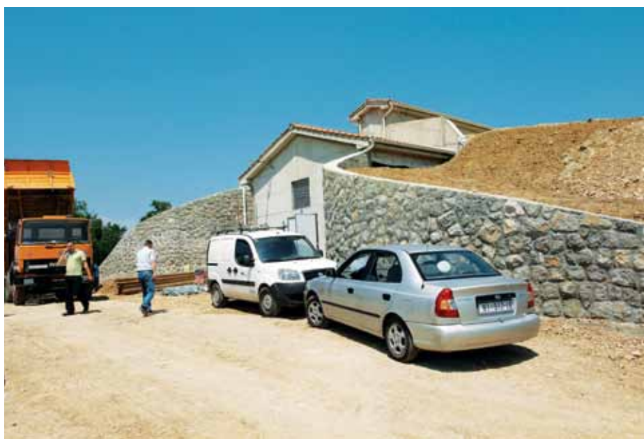
Izgradnja vodospreme "Pećinica"
