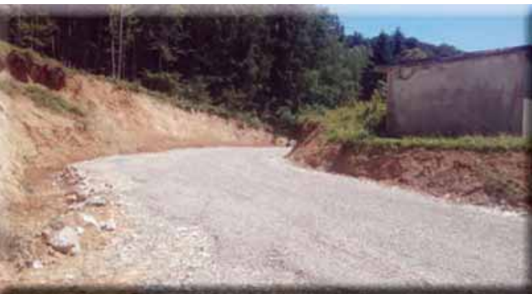
Izgrađena cesta kroz radnu zonu
