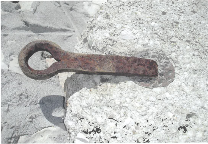
Željezna poluga pričvršćena olovom za gornji mlinski kamen
