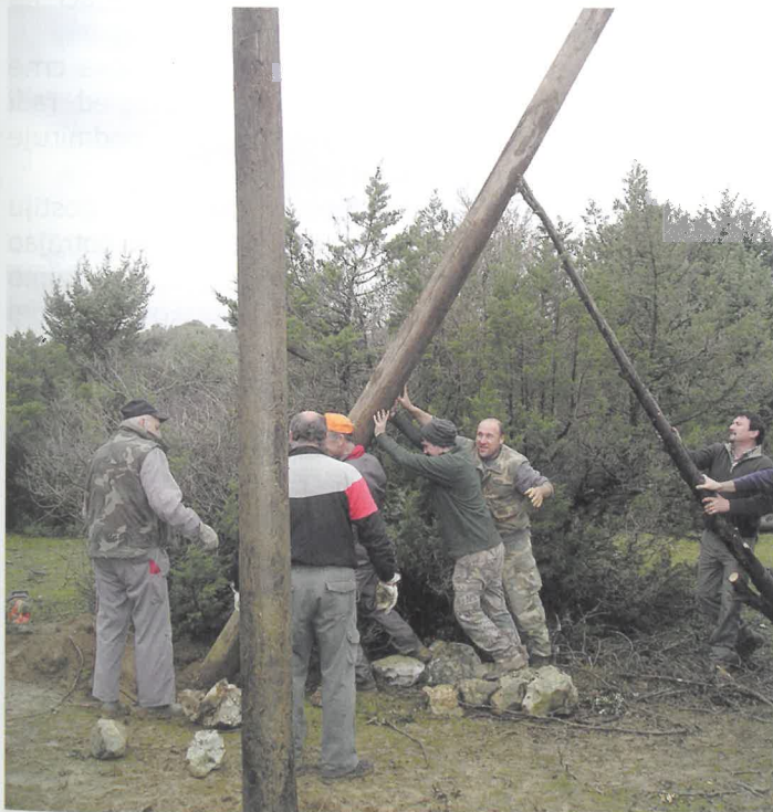
Izgradnja čeke na predjelu Brestrine
