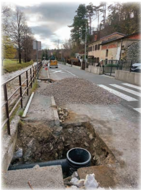
U prometnom smislu 2022. godina završila je postavljanjem prometne signalizacije i ležećeg policajca na ulazu u središte Klane
