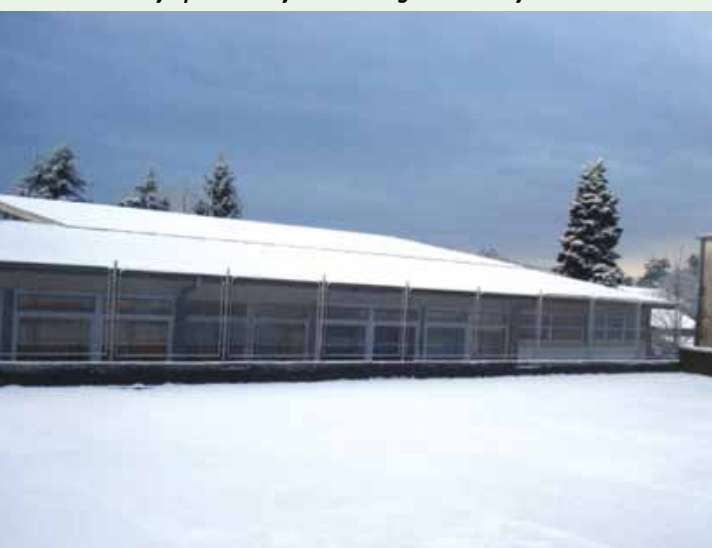
Završeni su radovi na zamjeni krova u školskoj sportskoj dvorani
