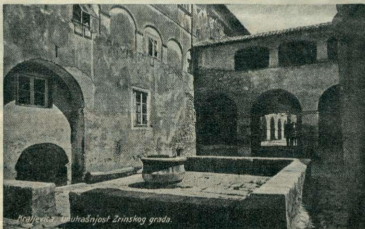
Unutrašnjost novog Zrinskog grada
