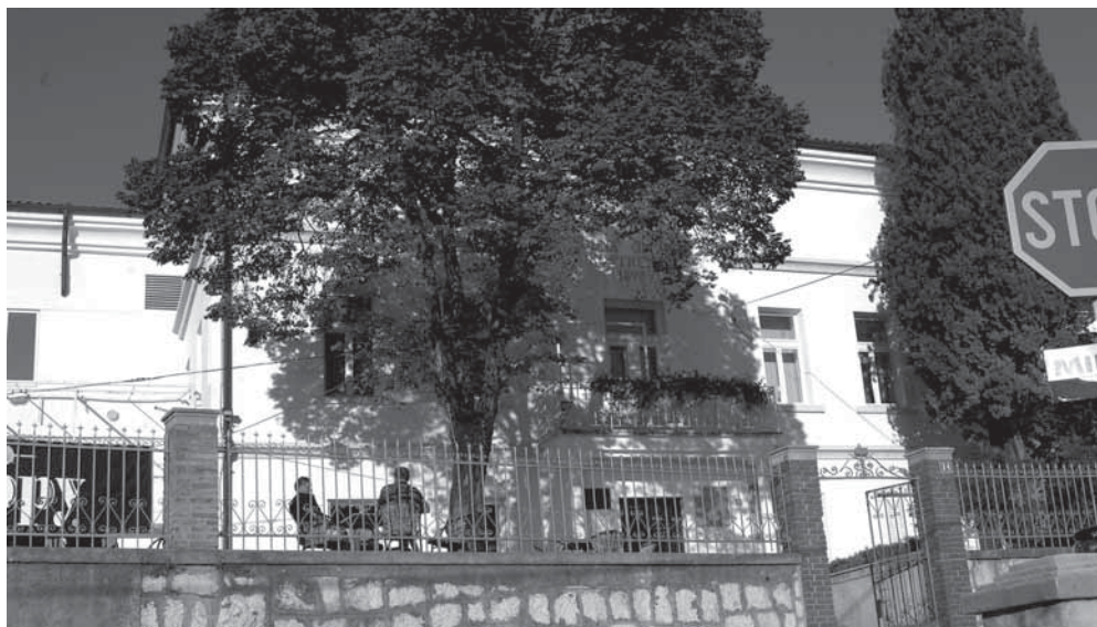
Zgrada Narodne čitaonice u Svetoj Luciji izgrađena je 1896. godine
