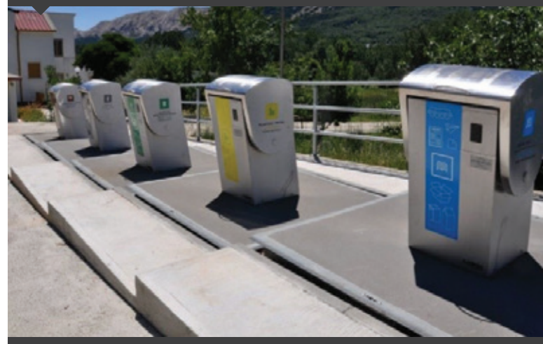
Ukopani spremnici u Jurandvoru
