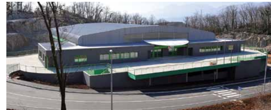
Najznačajniji projekt je izgradnja sportske dvorane, vrijedan 30 milijuna kuna
