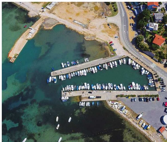
Radovi u budućoj Luci Melak obuhvaćaju izgradnju glavnog zaštitnog lukobrana dužine 120 metara
