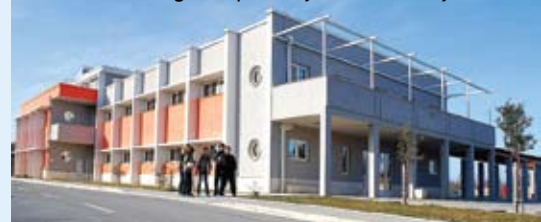
Nova školska zgrada ponos je svih Dobrinjaca
