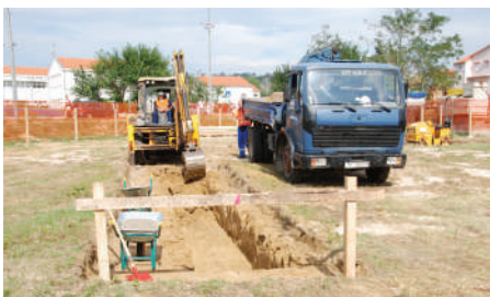
Početak radova na budućoj sportskoj dvorani
