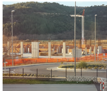
Radovi na novoj sportskoj dvorani u punom jeku (foto: D. Šanić)
