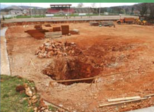
U Čavlima je u tijeku izgradnja veće školske sportske dvorane koju će uz školarce moći koristiti i sportaši Grobnišćine
